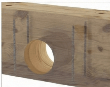
Vystuženie nosníka v mieste oslabenom vŕtaným otvorom
