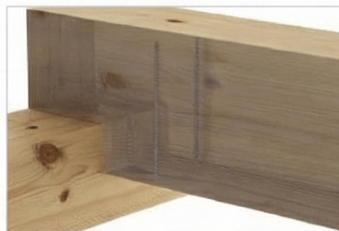
Ochrana proti zlyhaniu nosníka so zárezom
